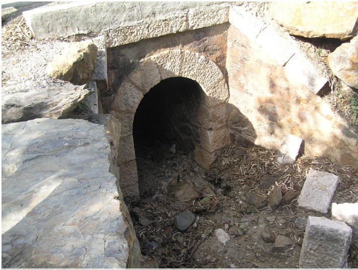
F2 Sección bóveda aguas arriba
