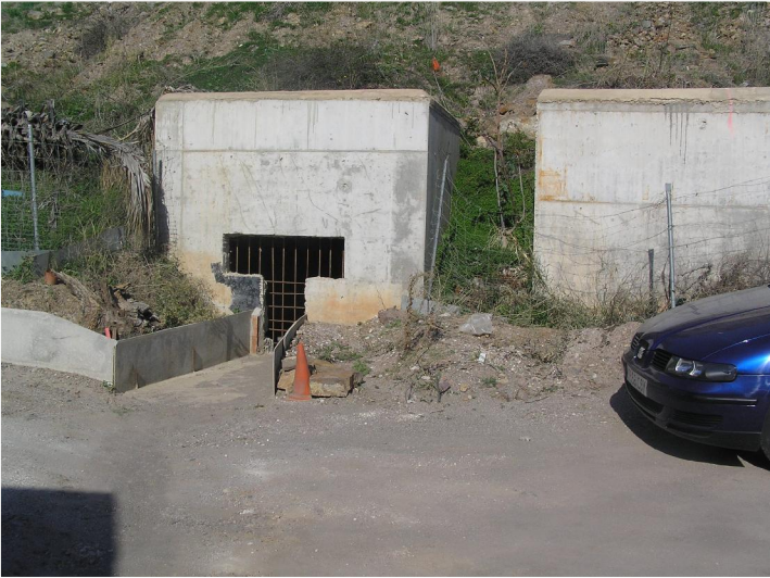
F1 Arquete de salida de la autovia
