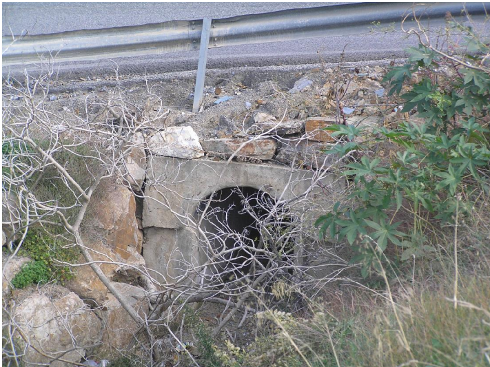
F2 Sección bóveda aguas abajo
