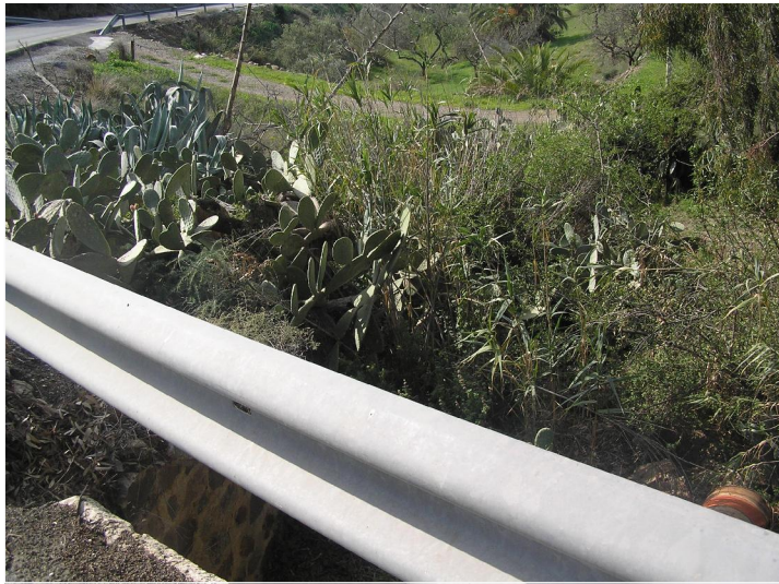
F3 Seccion cauce aguas abajo
