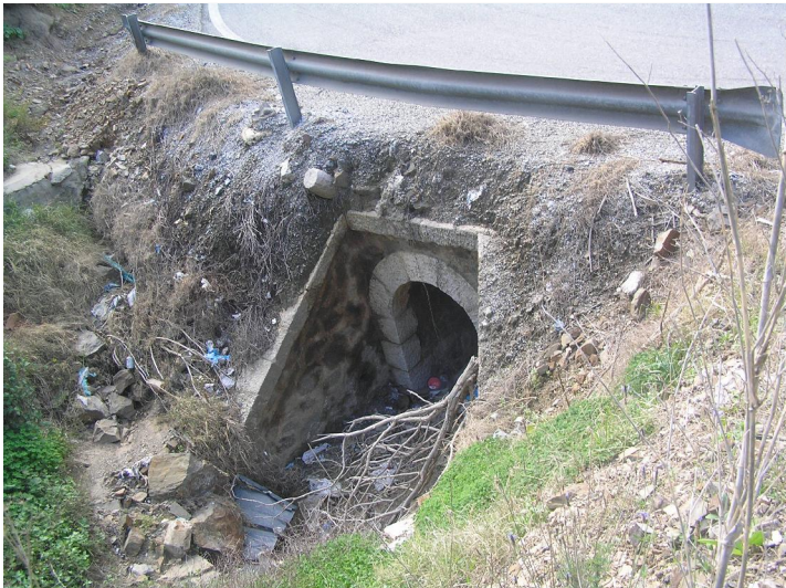
F4 Sección bóveda aguas arriba
