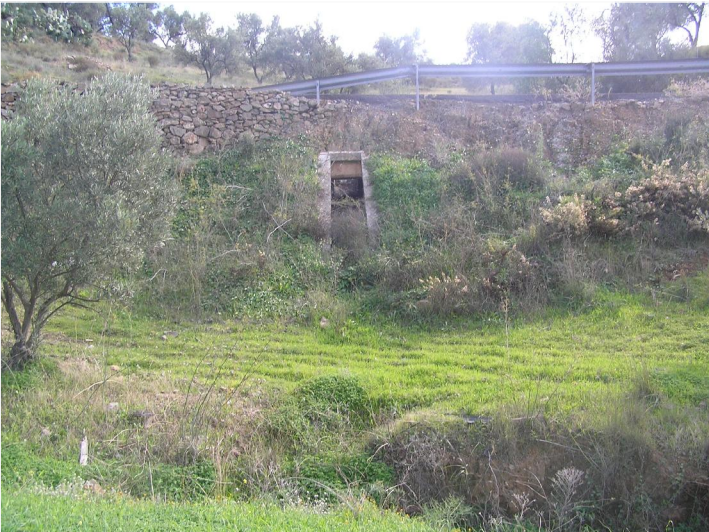
F3 Obra de drenaje de la carretera que desemboca en el arroyo
